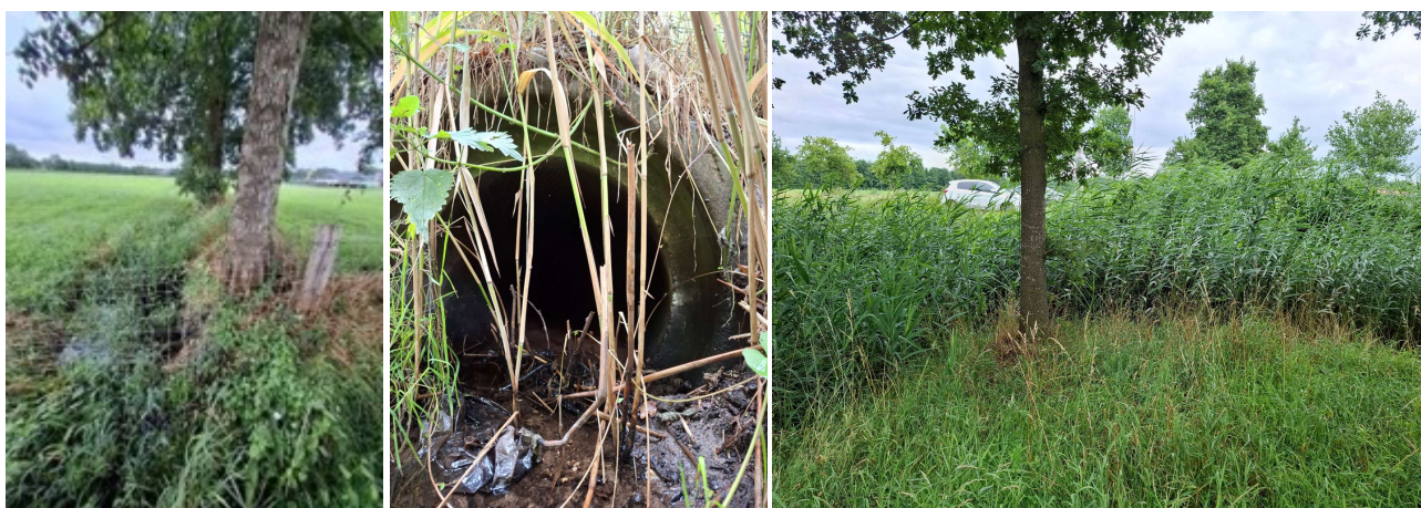
TUNNELBUIS ONDER DR. WILLEM DREESLAAN
