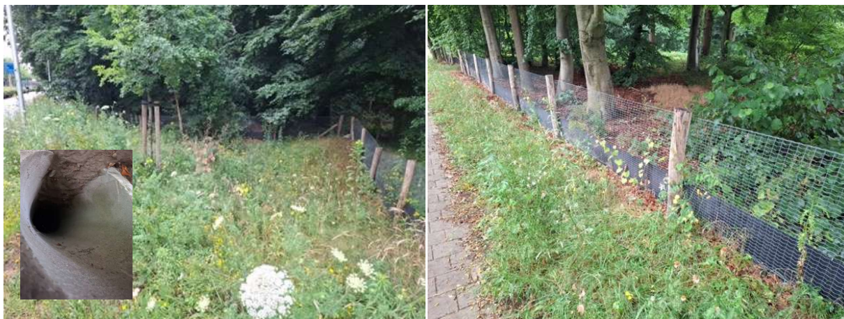
NOORDELIJKE TUNNELBUIS ONDER EDESEWEG MET TOEGELEIDENDE HEKKEN
