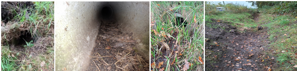
MIDDELSTE TUNNELBUIS MANSHOLT LAAN: INGANGEN EN TUNNELBUIS DROOG, GELEIDING
